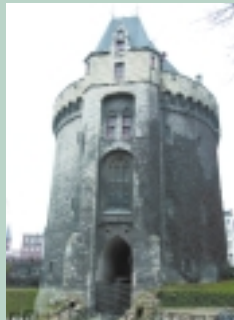
ENCEINTE (DEUXIEME) • PORTE DE HAL
